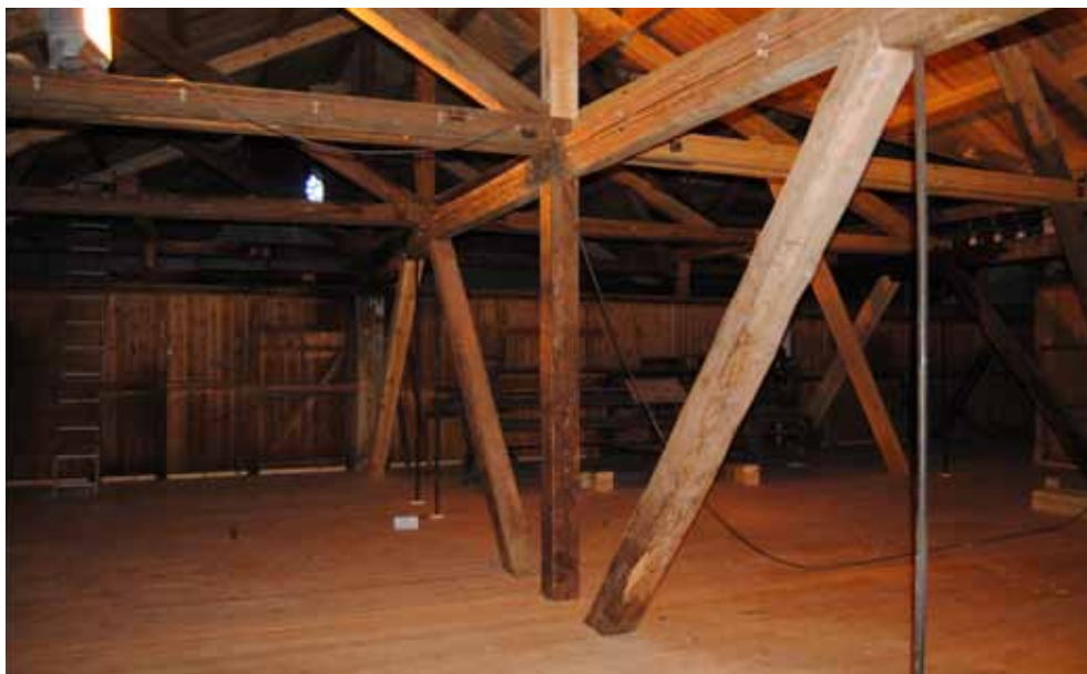
Loftet i tresliperiet etter restaurering
