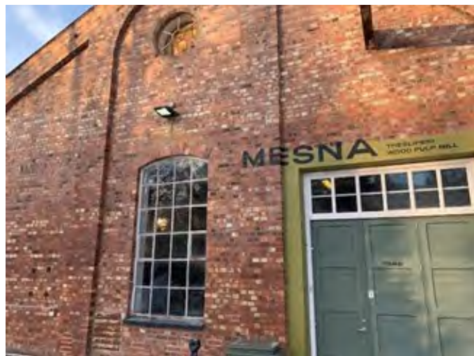
MESNA (sør-vegg), reparasjon og utskifting av teglstein.
